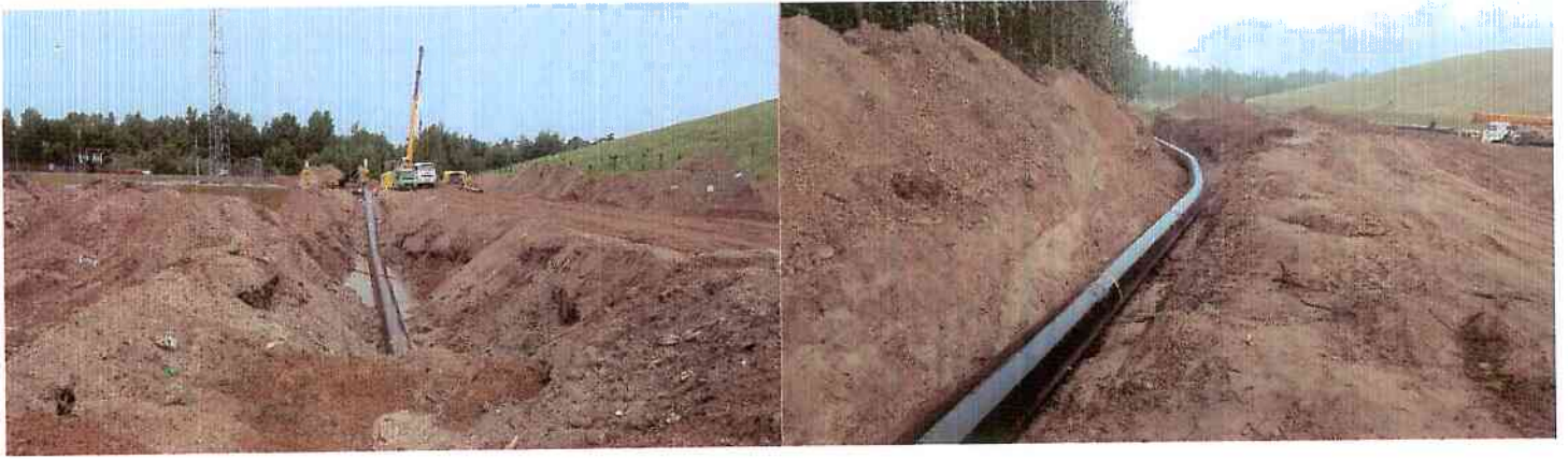
2.4 pav. MD tiesimo pavyzdžiai. MD tiesimas ir darbų zona kalvos papėdėje bei posūkyje
